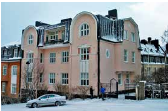
Engelaukea no 7, rakennusmestari Eino Engelbert Leino, v. 1912
