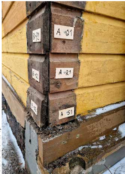
Kuva: IKJ Rakennus Oy.
