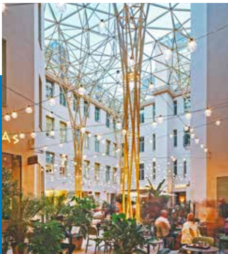
Kannen kuva: Pohjoisesplanadi 37:n laajassa peruskorjauksessa entinen pysäköintialue on muutettu veistoksellisen lasikaton alla sijaitseväksi lämpimäksi sisätilaksi. Lasikatetta kannattelee neljä suurikokoista teräsrastikkopilaria. JKMM Arkkitehtien suunnittelema kohde sai Vuoden Teräsrakenne 2025 tunnustuksen. Kuva: Mika Huisman
