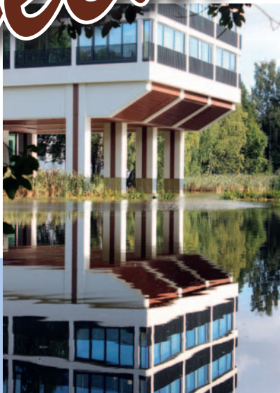
Kannen kuva: Koneen vanhassa pääkonttorissa Munkkiniemessä on nyt toimistojen sijasta 83 asuntoa. Rakennus ulottuu osin viereisen lammen päälle. Kuva: Sirkka Saarinen
